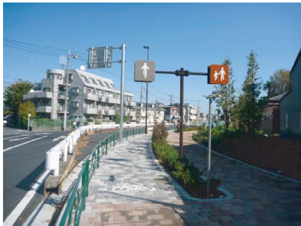
開通した歩道部（平成25年11月）、歩道と自転車レーンは舗石の色も変え、間は植樹帯で区切られている。
