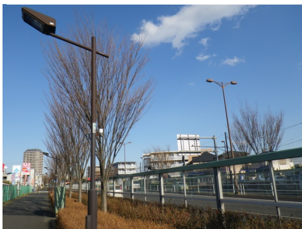
会の働きかけによって設置された透光型の遮音壁
