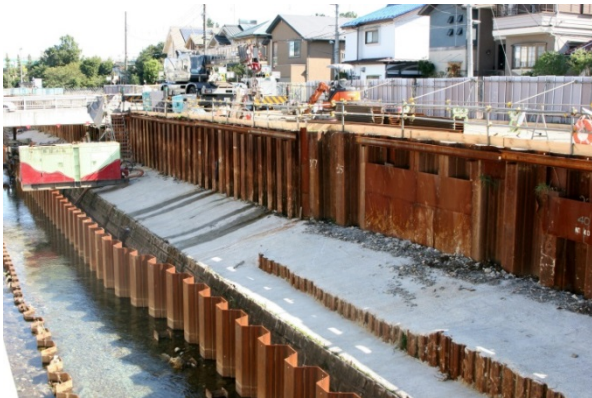
写真-3 工事中の緩斜面 (25年10月27日現在)
