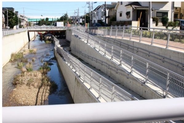
写真-4 デッキテラスの一部完成した箇所 (25年10月27日現在)
