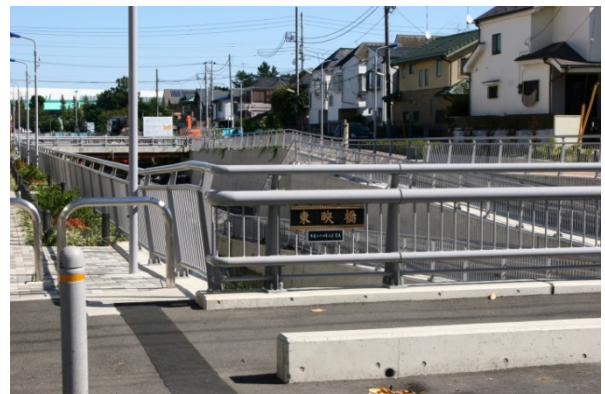
写真-5 親柱のない高欄と防護柵 (25年10月27日現在)
