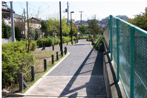
写真-2 御園橋下流左岸(2) (25年10月27日現在)
