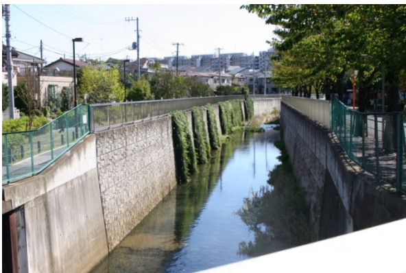
写真-1 御園橋下流左岸(1) (25年10月27日現在)
