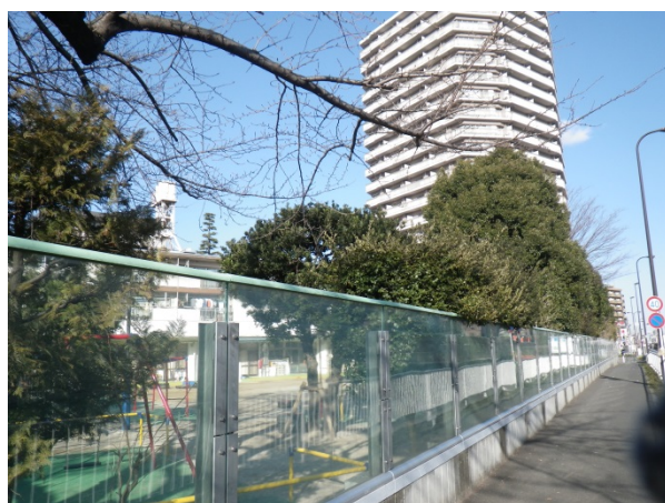
保育園に設置された窓型の遮音塀
