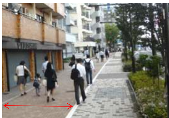
歩道有効幅員約3.5m
