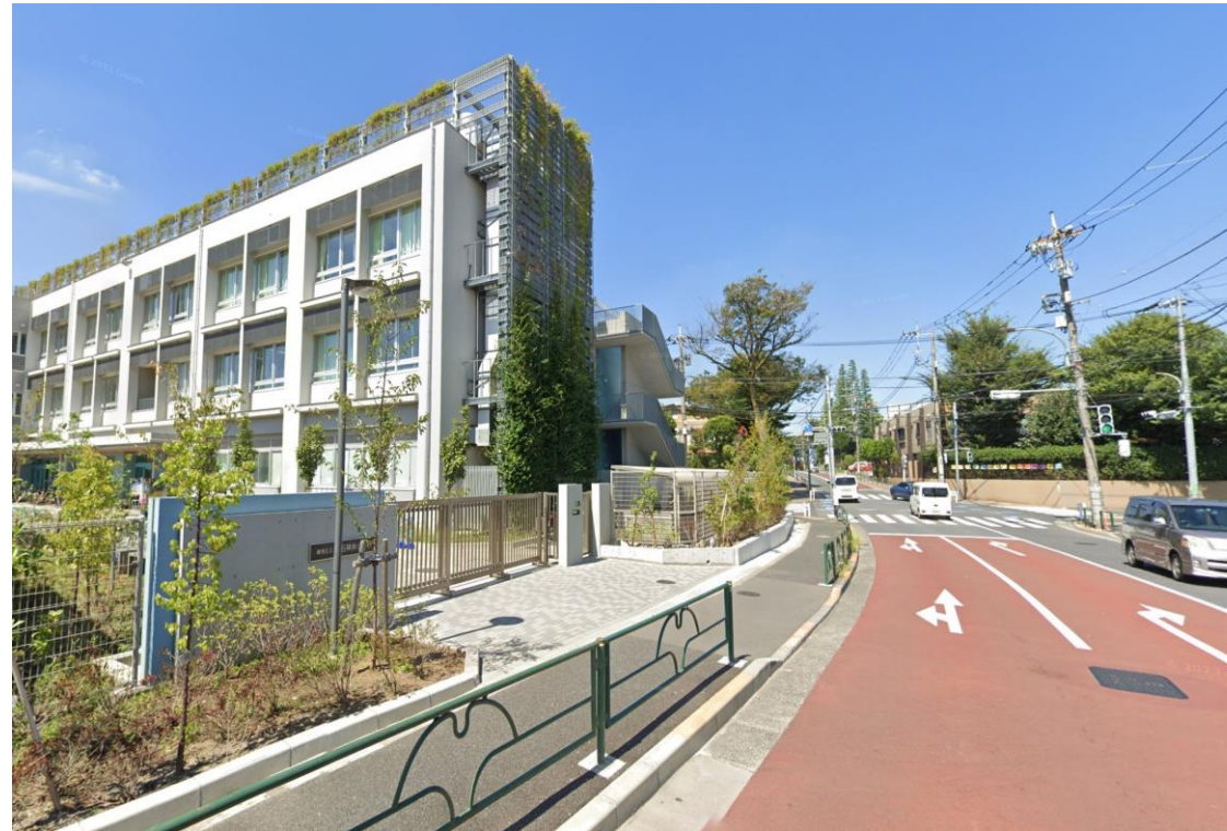
都市計画道路に面した学校 (石神井小学校)
