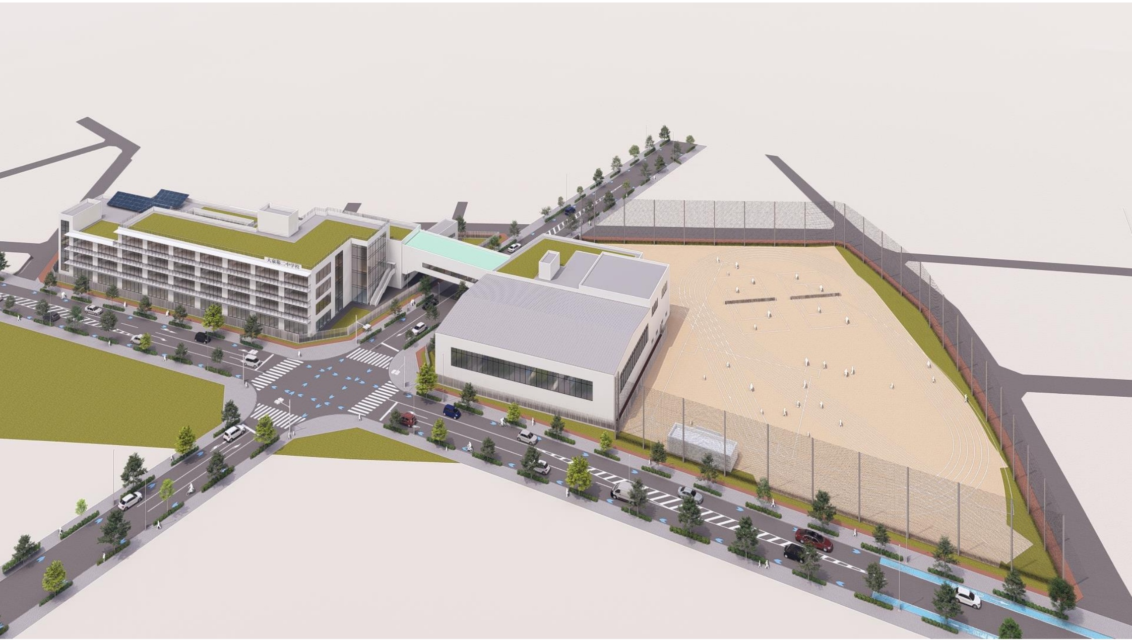
全景 南側上空より
