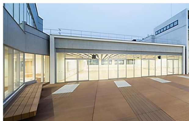
▲校舎屋上【豊玉第二中学校】
