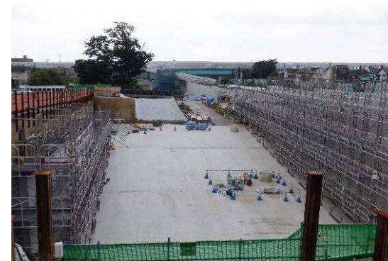
Fランプ(F8-UからF11-L)の擁壁構築状況(2021年7月16日)
