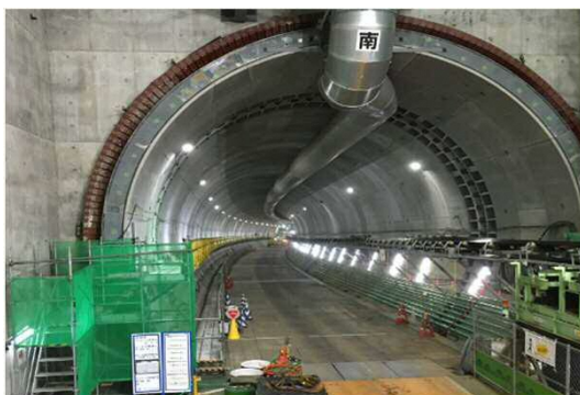
大泉南 開削部・Fランプシールドのセグメント組立後の状況(2020年6月19日)
