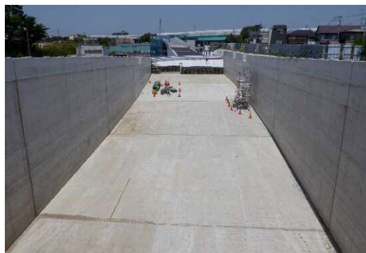
Bランプ構造物施工完了箇所(直轄施工区間)(2021年4月11日)
