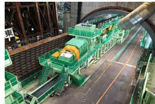
立坑全景写真 (2021年7月26日)
