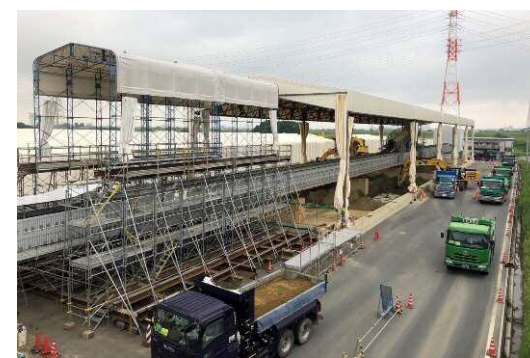
土砂仮置き場における、 ベルトコンベアの終着点の様子（2020年6月27日）
