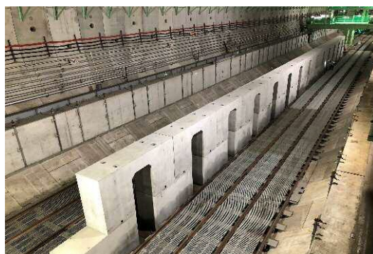
中壁設置状況 (2021年7月26日)
