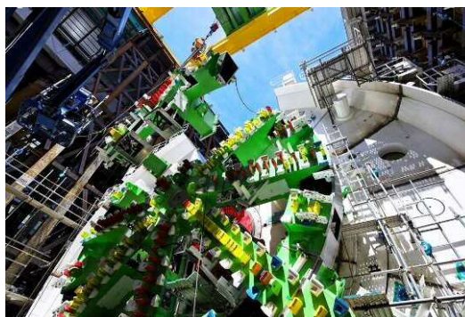
シールド機カッタ部の投入・組立を行っている状況（2018年4月27日）
