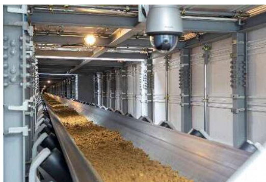
シールドマシンによって掘削した土砂を、 ベルトコンベアに乗せて仮置き場へ搬送する様子（2019年9月18日）
