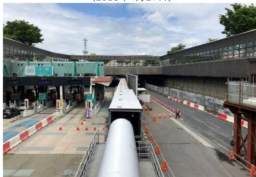
外環道のベルトコンベア 料金所部の状況（2020年6月27日）
