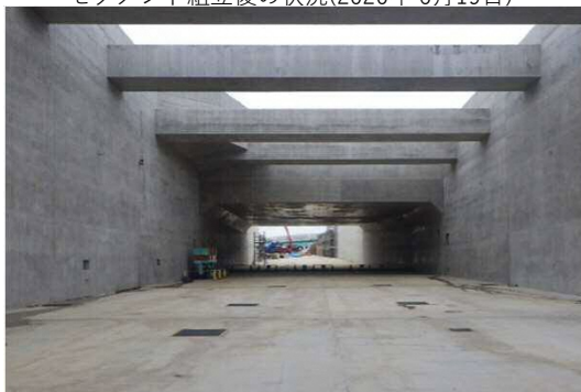
大泉南 開削部のBランプ料金所躯体構築・U型カルバートが完了した状況(2020年6月19日)
