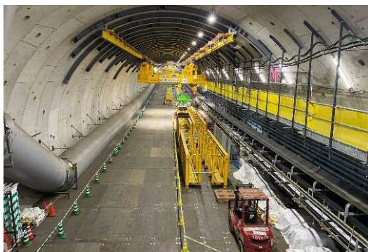
トンネル坑内の状況 坑口側から切羽側を望む（2021年3月29日）
