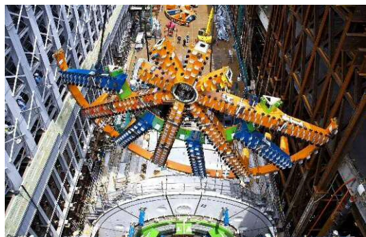
大泉JCT北行シールドマシンの組立状況 (2018年6月22日)
