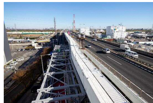
外環道のベルトコンベア 新倉PAの状況（2020年6月20日）
