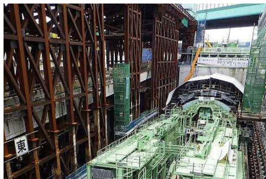
シールドマシンの後続台車を組み立てている状況 (2018年9月18日)
