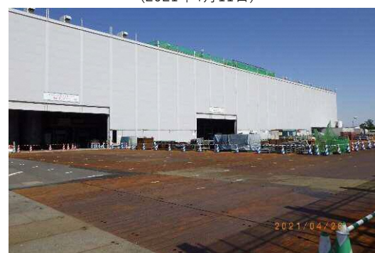
大泉南 開削部 路面覆工の設置を完了した状況(2021年4月26日)
