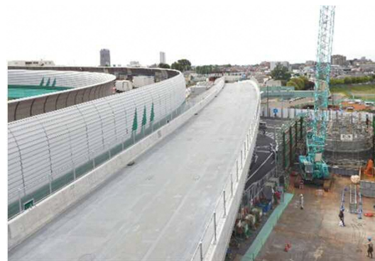
大泉JCT Aランプ 第二橋(仮称)の地覆壁高欄施工・側足場撤去完了(2021年5月12日)
