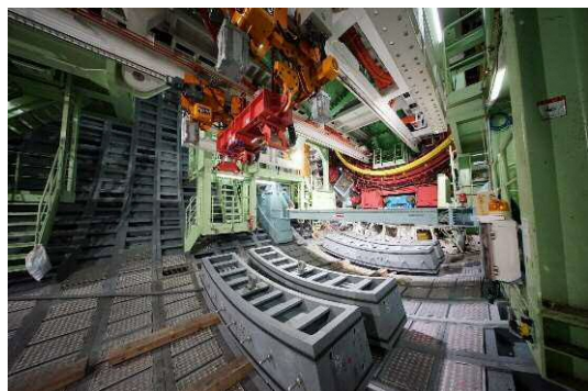
セグメント組立て状況写真 (2019年5月23日)
