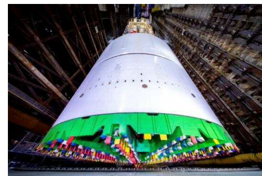
シールドマシン組立状況の全景写真（2018年10月25日）
