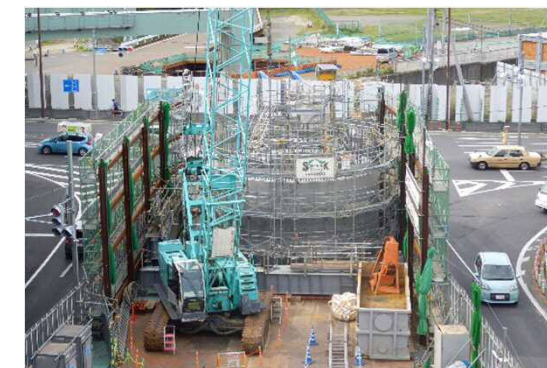
大泉JCT CP3ケーソン基礎施工状況(2021年5月12日)
