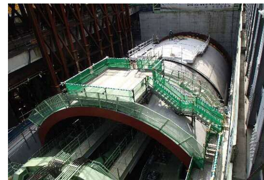
シールド機組立完了状況 (2019年1月27日)
