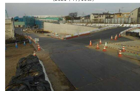
東側工事用道路からの搬入路となる工事用道路の状況(2020年12月14日)
