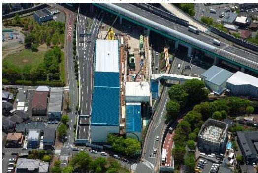
シールド発進立坑部の全景写真（2021年4月19日）
