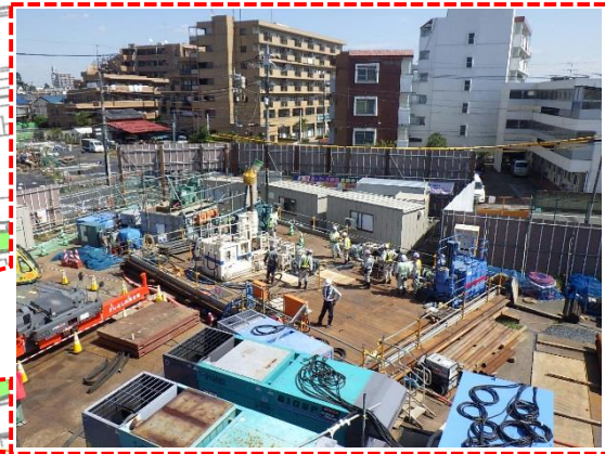
地盤改良工事の様子
