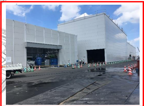
防音ハウス設置
