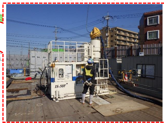
工事機械(一部)
