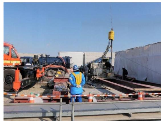
工事をするために事前に地盤の弱い所を補強（改良）します。
