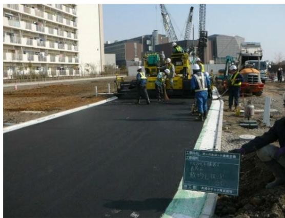
工事車両が通行するための工所用道路を、防音パネル内側に整備します。
