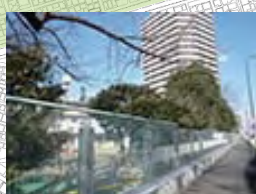
A166 窓型の遮音壁が設置された春日町第三保育園
