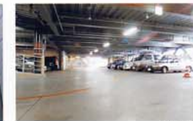
B棟駐車場
