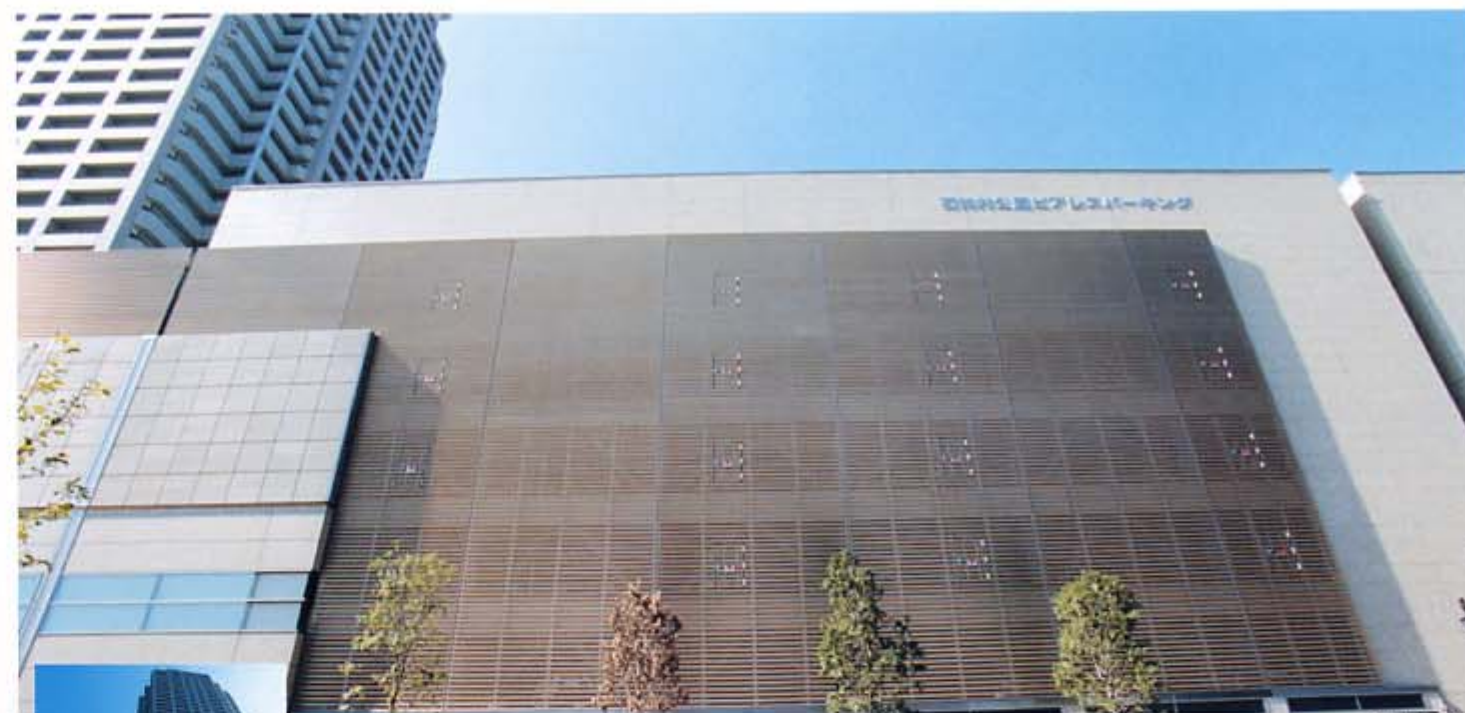
B棟駐車場外観
