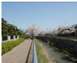
根ヶ原橋下流付近
