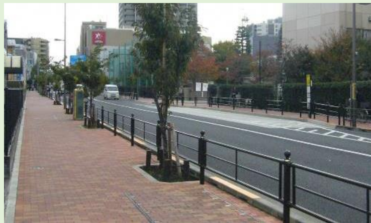
整備事例：都市計画道路補助 132 号線 (幅員 16m、石神井町二丁目付近)
