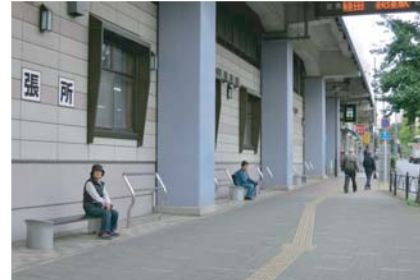
高架下利用として、練馬区谷原出張所が整備されています。
