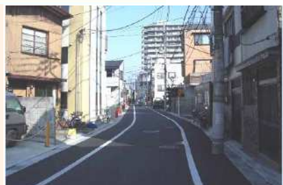
道路整備の事例（北町地区）
