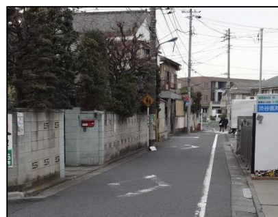
ブロック塀（事例）
