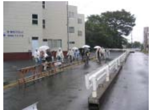
写真 整備中の補助133号線
