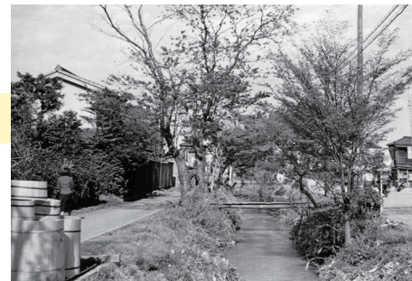
暗渠化前の千川上水
