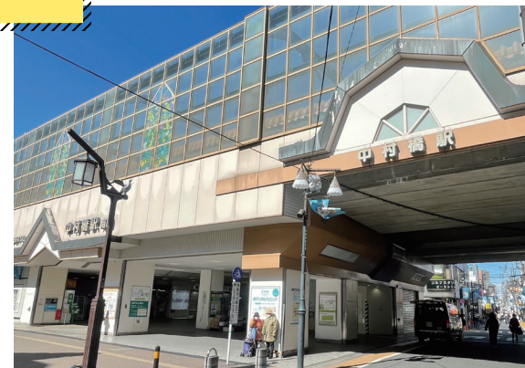
池袋線高架化後の新駅舎
