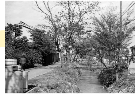
暗渠化前の千川上水
