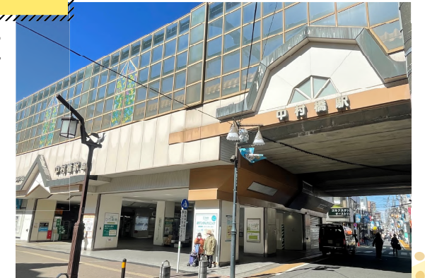
池袋線高架化後の新駅舎
