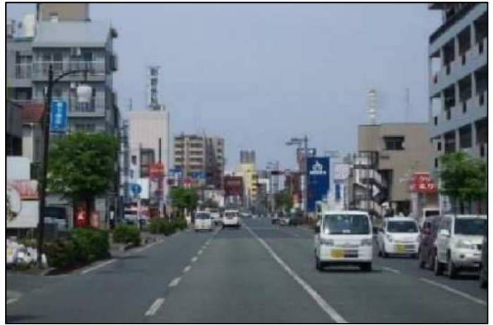
無電柱区間(被害なし)(県道 28 号(緊急輸送道路))
