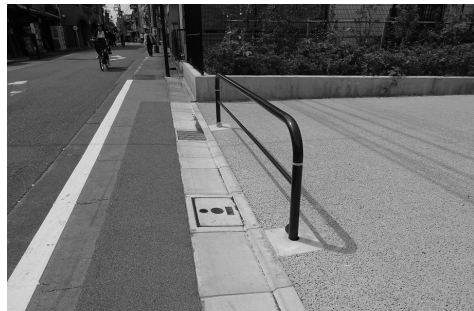
飛び出しやバイク等の侵入を抑えるガードパイプ
