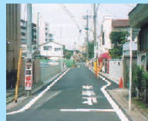
整備後(幅員6m)
