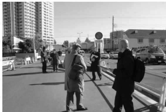
土地区画整理事業で整備中の道路
