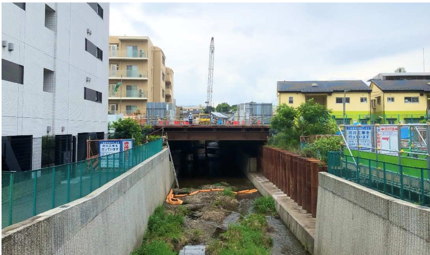
白子川の工事ヤード
