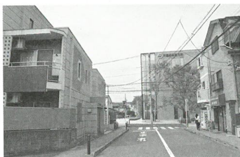
▲生活幹線道路A路線2工区
