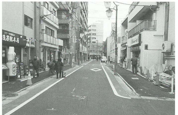
生活幹線道路A路線5工区(江古田駅側から)▲
