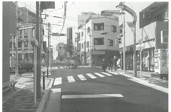
整備の完了したA路線4工区▲
