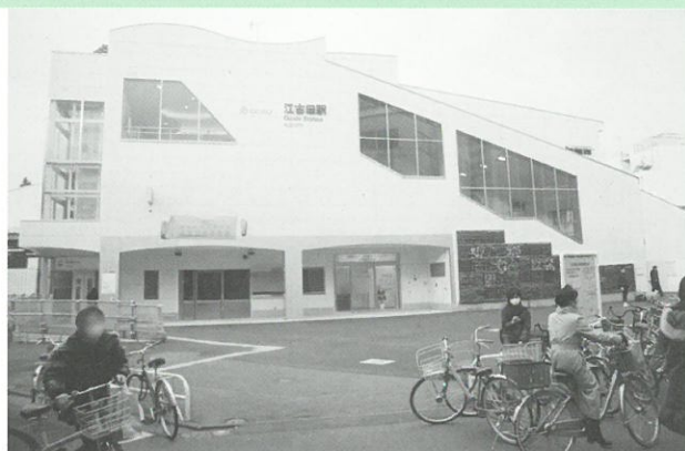
完成した駅舎▲
