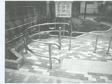
車いすゲート
