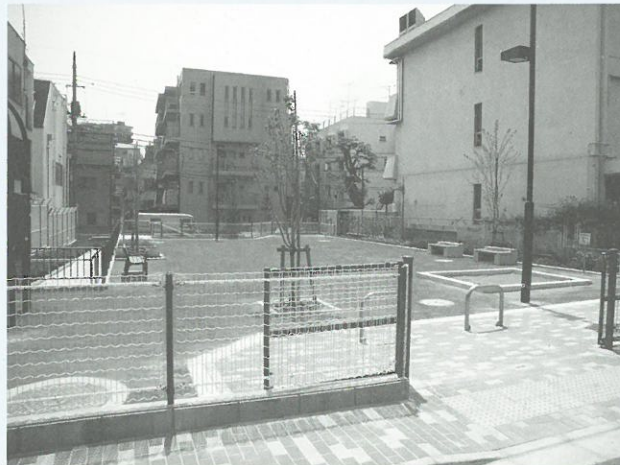
全景(北側より)
