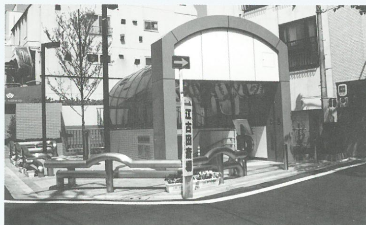
「江古田地下横断歩道」の建設に伴い、道路幅員を広げ、ちょっと座れるミニ広場ができました(栄町32)
