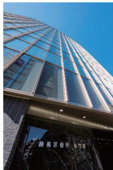
オープンした北庁舎
