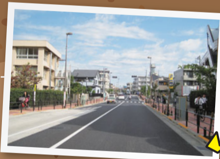
電柱がなくなった光和小前の道路
