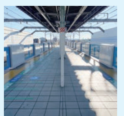
▲6年に設置が完了した練馬高野台駅
