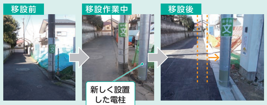
〈支障物(電柱)の移設〉
