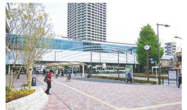
連続立体交差化が完了した石神井公園駅
