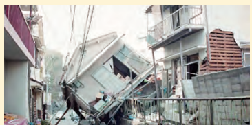
阪神・淡路大震災の被災の様子(写真提供:神戸市)
