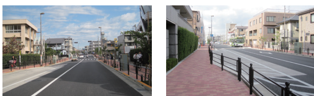
無電柱化が完了した石神井町2丁目の補助132号線
