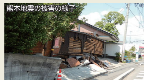
塀が倒壊すると、人身被害だけでなく、避難や救助・消防活動などの妨げになります
