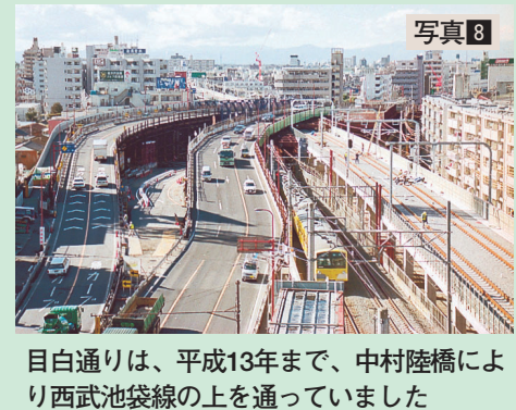
目白通りは、平成13年まで、中村陸橋により西武池袋線の上を通過していました
