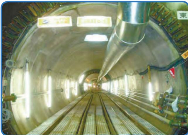
東京都が道路の下に設置した高さ約4mの雨水をためる貯留管
