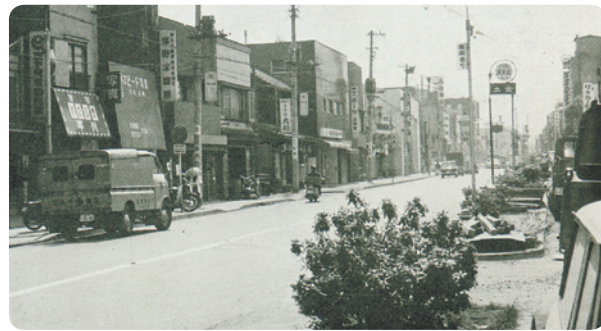
昭和44年頃の同所。千川上水は埋められ、桜は全てなくなっていた
