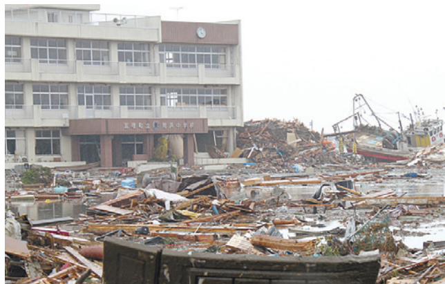
津波から多くの命を守った荒浜中学校。現在は解体中で、平成26年8月に新校舎が完成する予定です
