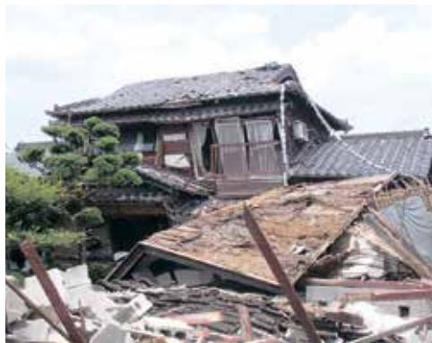
熊本地震による被害
