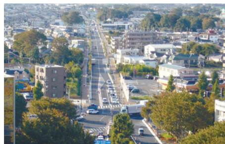
都営大江戸線延伸の導入空間となる補助230号線
