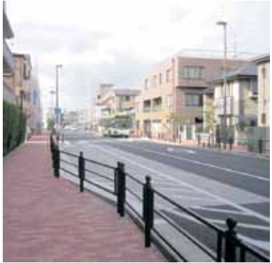
無電柱化が完了した石神井町2丁目補助132号線
