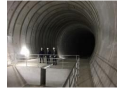
▲白子川地下調節池
