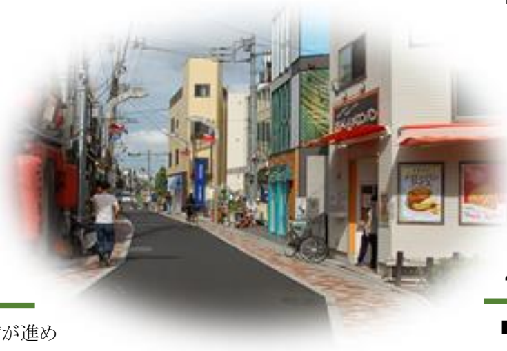
▲密集事業により拡幅整備した道路
