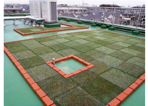
(既存製品による屋上緑化の事例)
