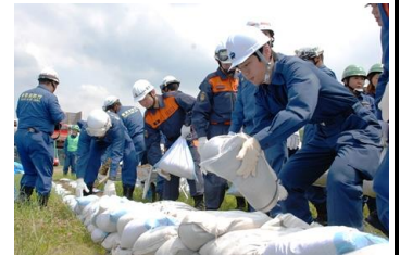
【土のう積みの様子】
