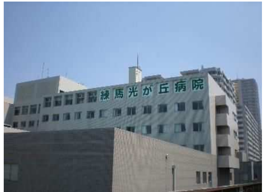
▲介護医療院を含む医療・介護の複合施設を整備（旧練馬光が丘病院）
