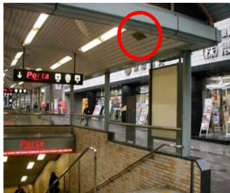
地下駅地上出入口における音響案内の例
