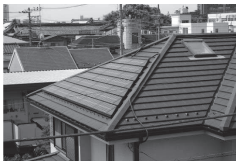
太陽光発電設備
