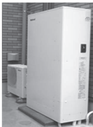
家庭用燃料電池システム（エネファーム） 自然冷媒ヒートポンプ給湯器（エコキュート）
